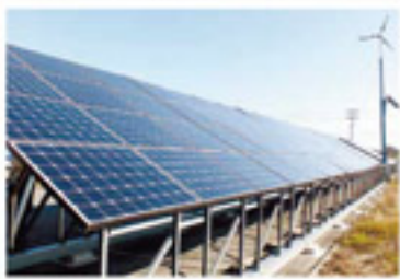
当社の岡山県倉敷市「マイクログリッド」工場の屋根に、4000㎡の太陽光パネルを設置しました。年間約1000kWhの発電量が期待できます。
